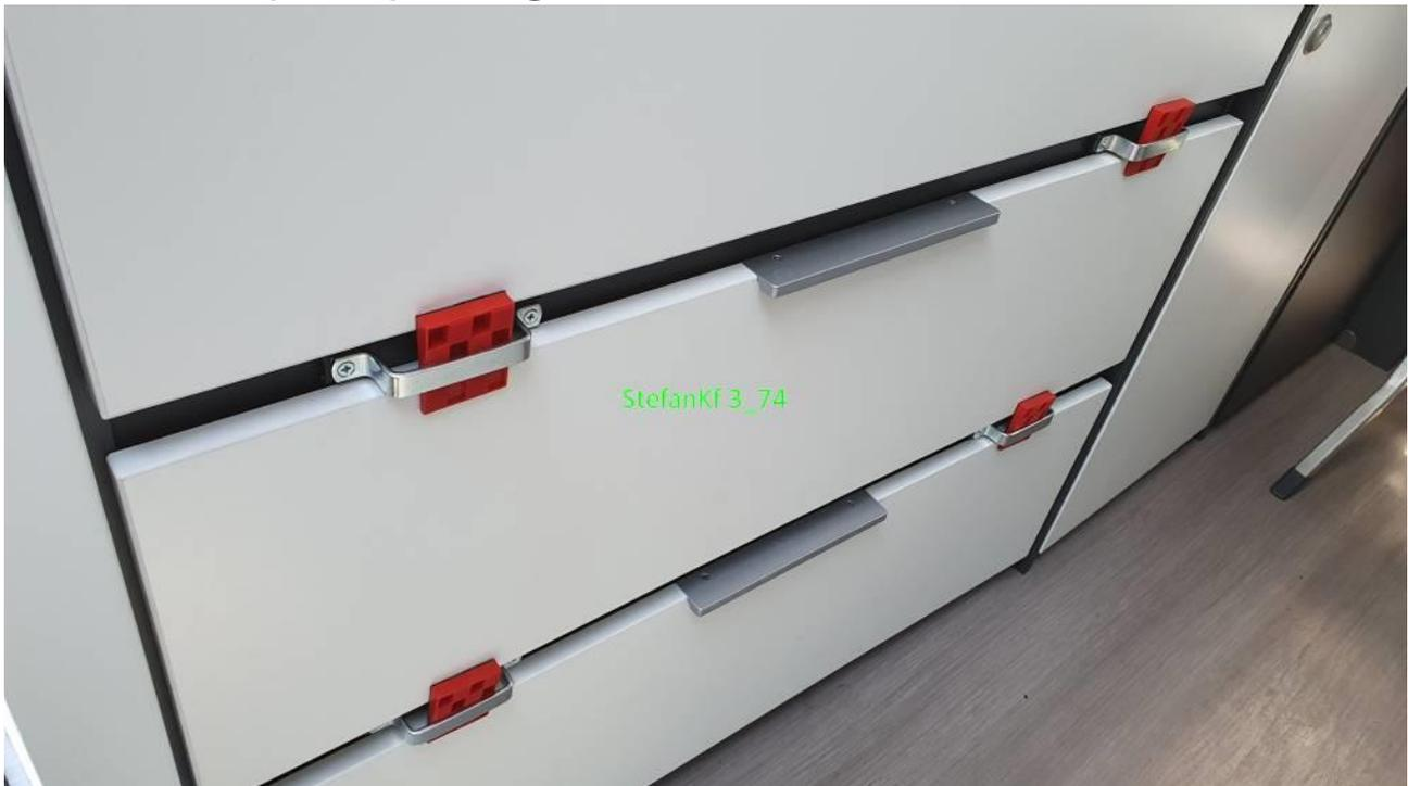
Schubladensicherung 4, Unterbringung Keile mit Hilfe einer schmalen Aluleiste
